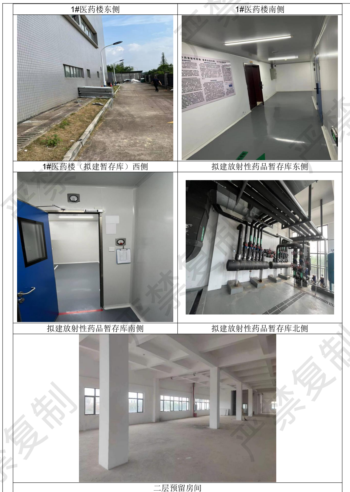
图8-2 拟建放射性药品暂存库周边情况
